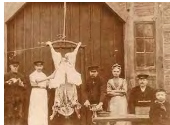
Hofschlachten in früheren Zeiten
