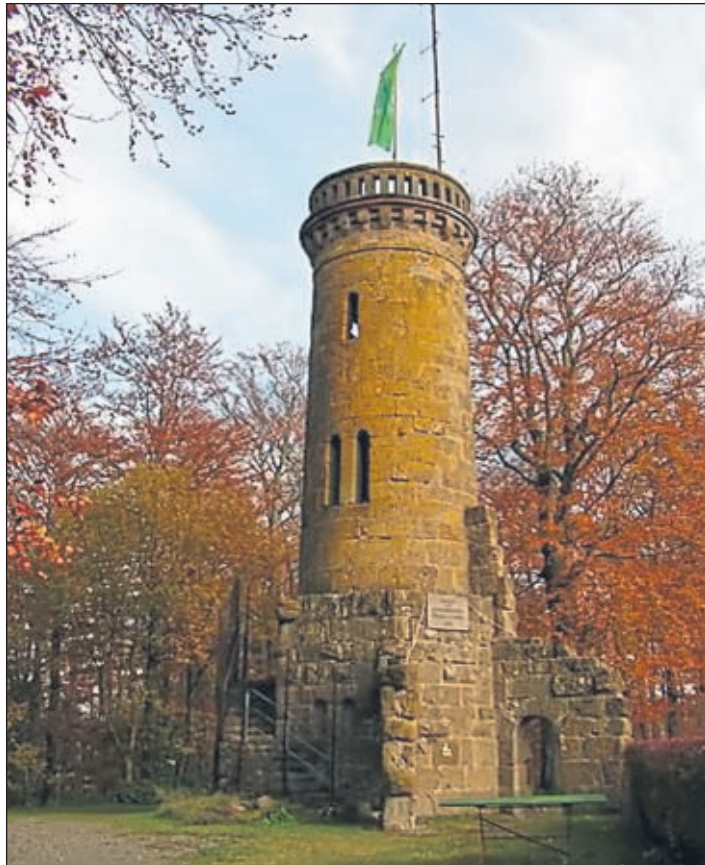
Auf dem Elfbuchenturm befindet sich die Technik für die Relais im 2m- und 23cm-Band
