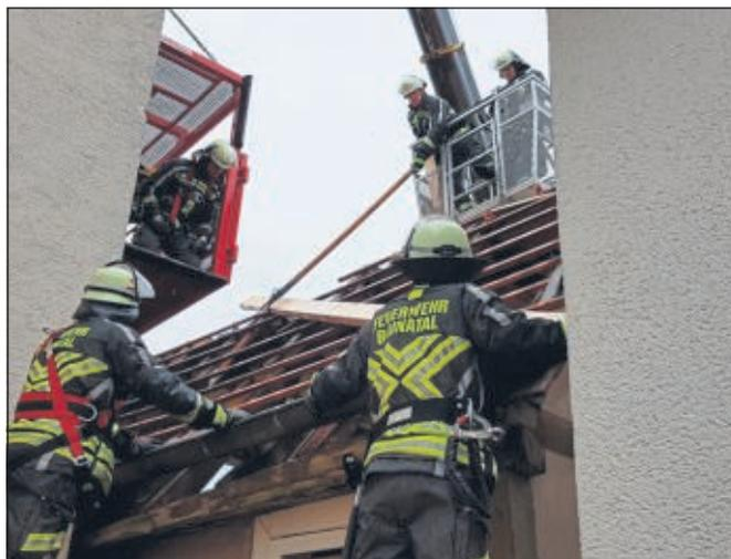
Die Baunataler Helfer beim Verstärken der Dachstuhlkonstruktion
