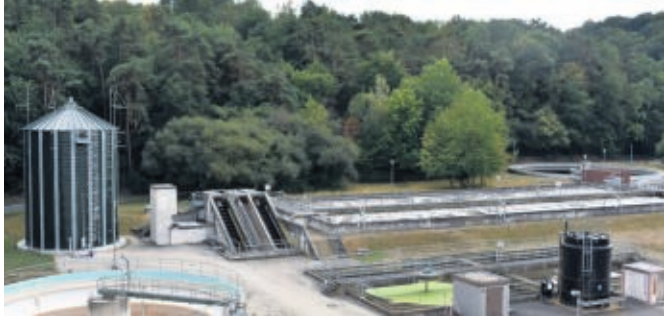
Die Verbandskläranlage in Kirchbauna.
