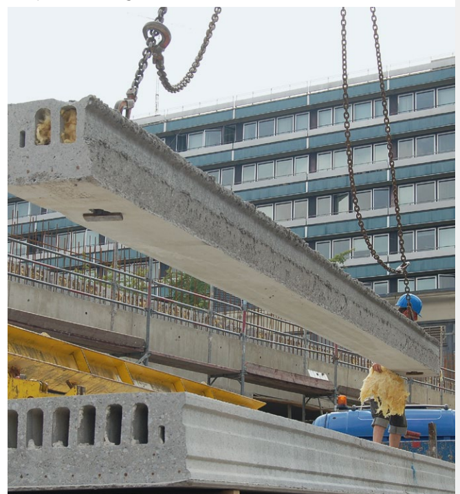
Passplattenmontage mit Hebeschlüssel
