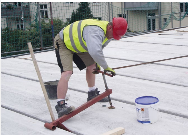
Höhenausgleich mit BRESPA® -Hebel
