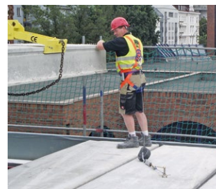
Montage mit Leenstra-Pistolenanker
