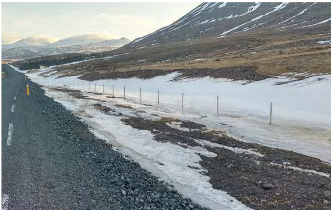
Nýlagður vegur og girðingin sett rétt við veginn þar sem er klaki og snjór þrátt fyrir hláku í marga daga. Örfáum metrum til hægri er bakki sem oftast er snjólítil eða snjólaus. Til hvers í fjáranum er verið að leggja girðinguna í lægðina?
