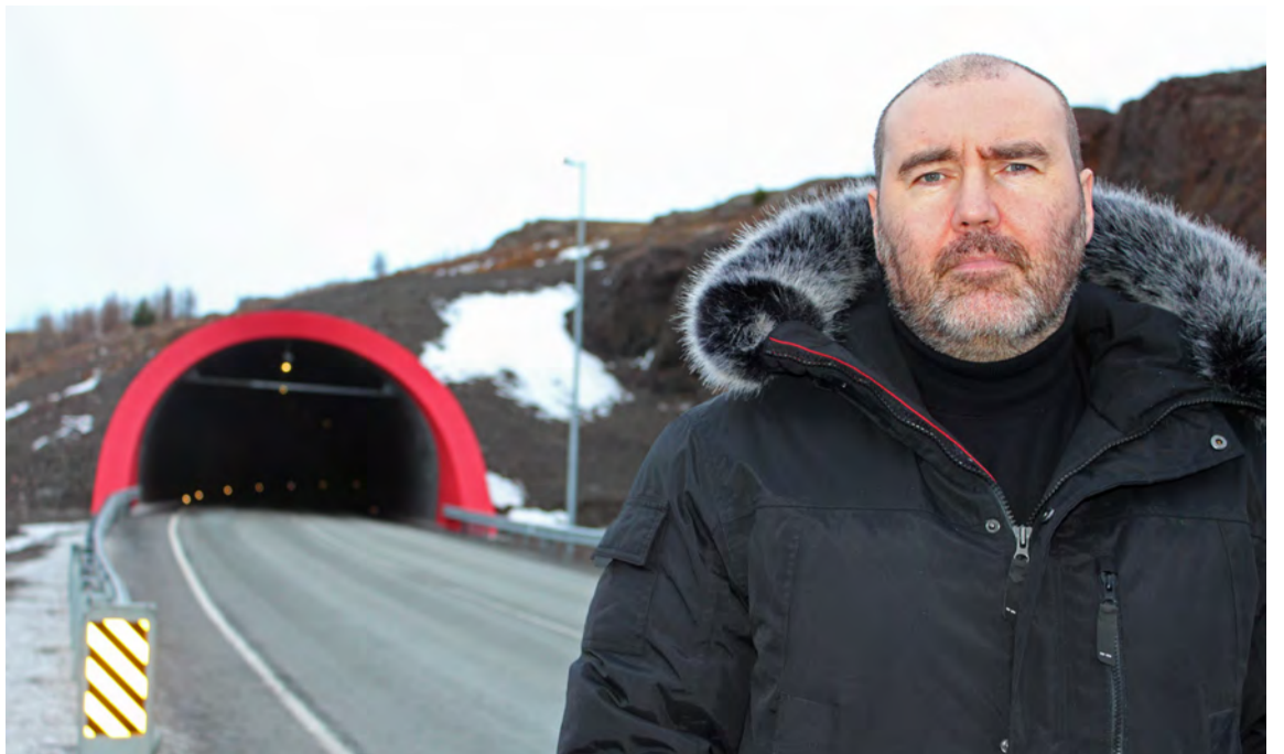
Valgeir Bergmann, framkvæmdastjóri Vaðlaheiðarganga. Mynd / MBP
