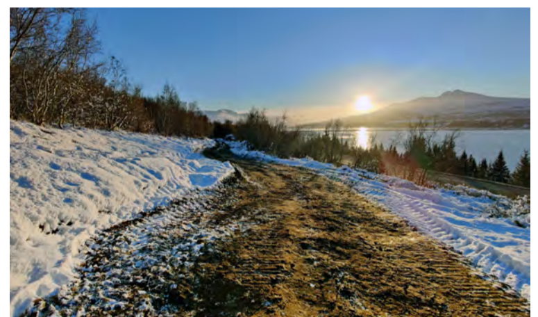
Lokið hefur verið við að grafa lagnaskurð í gegnum Vaðlareit og áætlað að lagnir verði komnar í skurðinn nú um miðjan janúar. Stefnt er að því að malbika stíginn á komandi hausti. Mynd / Svalbarðsstrandarhreppur
