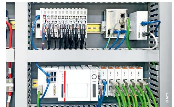
Ein Embedded-PC CX2020 und eine Vielzahl von EtherCAT-Klemmen ermöglichen die Erfassung digitaler und analoger Signale für die exakte Überwachung und Analyse der Prozessparameter in Vakuumdruckgussmaschinen.
