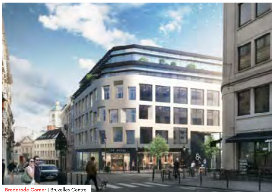
Brederode Corner | Bruxelles Centre
