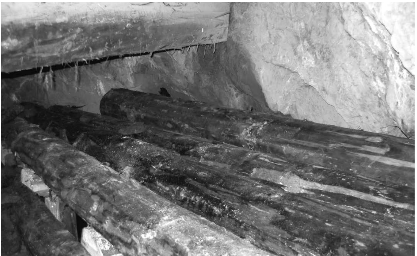
Seitenwand und Dach der halben Türstöcke.
