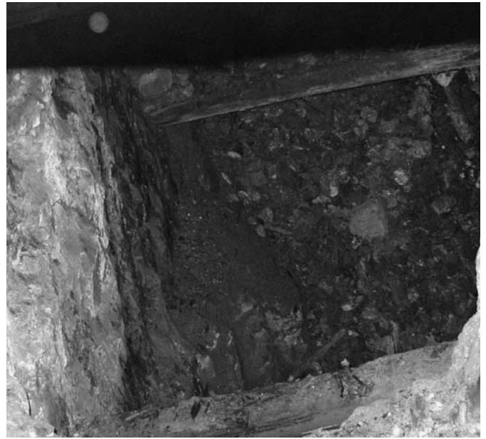
Schutt füllt den Schacht zum Tiefenstollen-Firstenbau.
