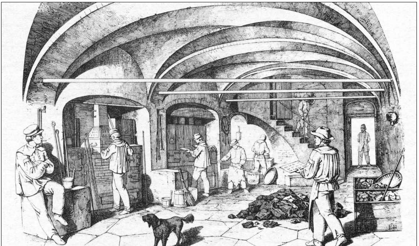
Probieröfen der Freiburger Hüttenwerke dienten als Vorbild für den Sinterofenbau.
