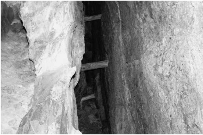
Im obersten Teil des Maximilian sind noch einige Stempel von Abbaubühnen vorhanden.
