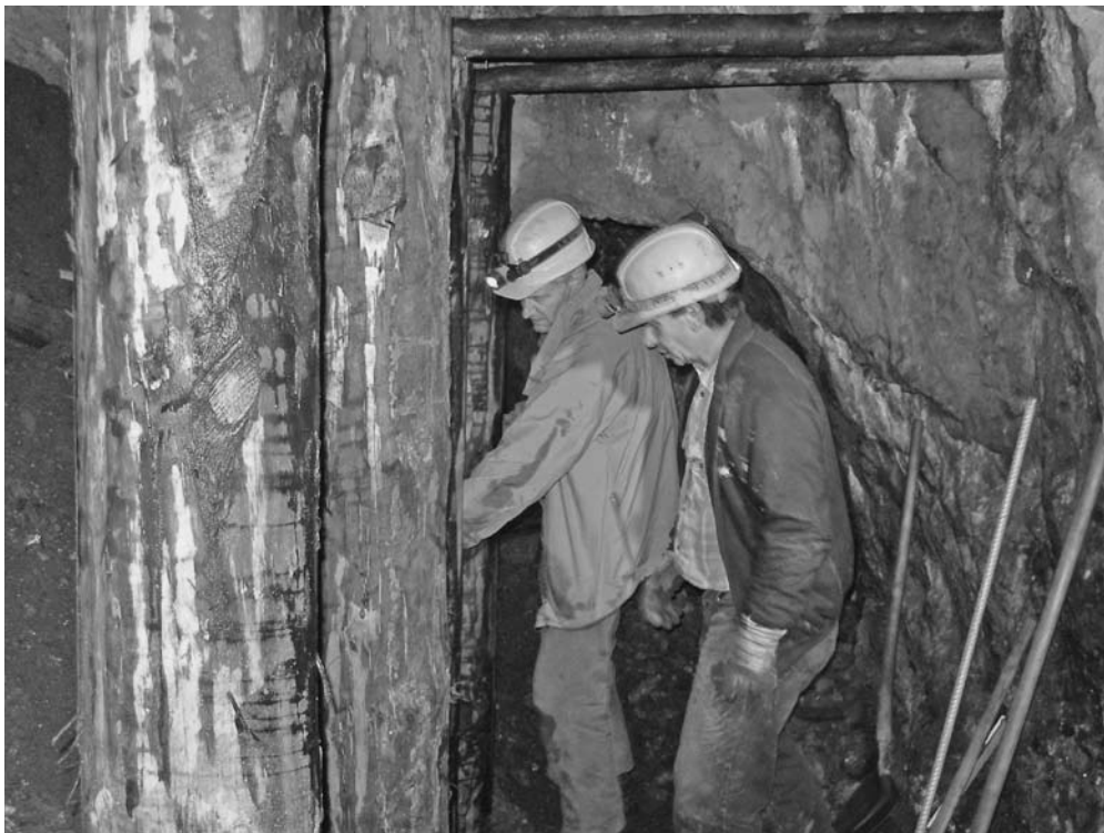
Sicherung des Durchganges.
