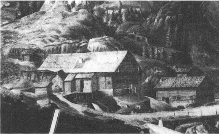
Abb. 10) Bildausschnitt Ofengebäude mit Wasserführung zur Radstube und aus dem Dach geführter Flammenofenese
