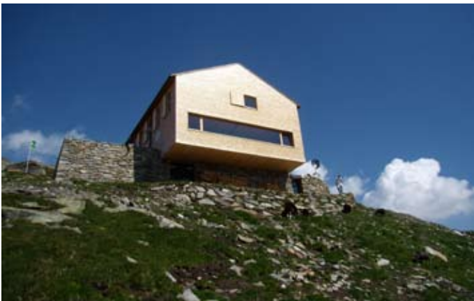
Die neue Olpererhütte, 2.389 m.
