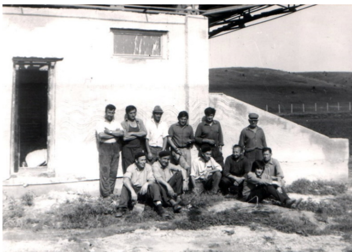
Brigádnici na stavbe tribúny
