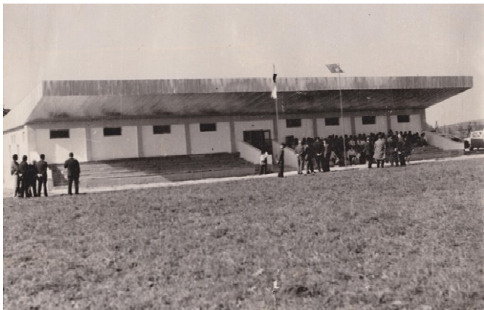
Futbalová tribúna postavená v 70. rokoch 20. storočia
