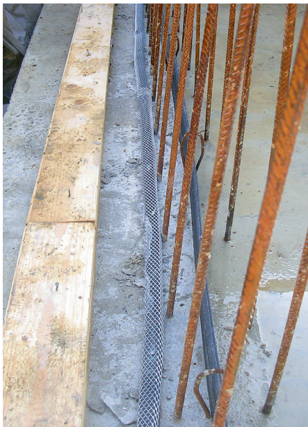
(7) Montiertes Quellband mit Regenschutz- hülle
