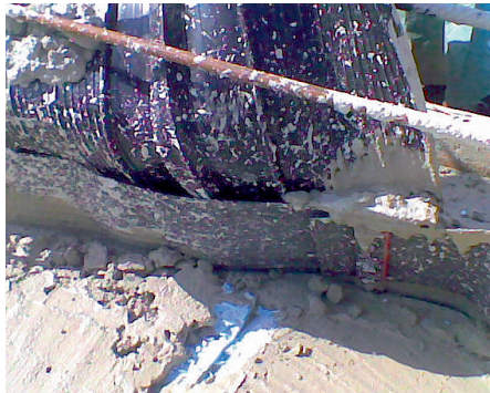
(4) Dehnfugenband und Dichtblech
