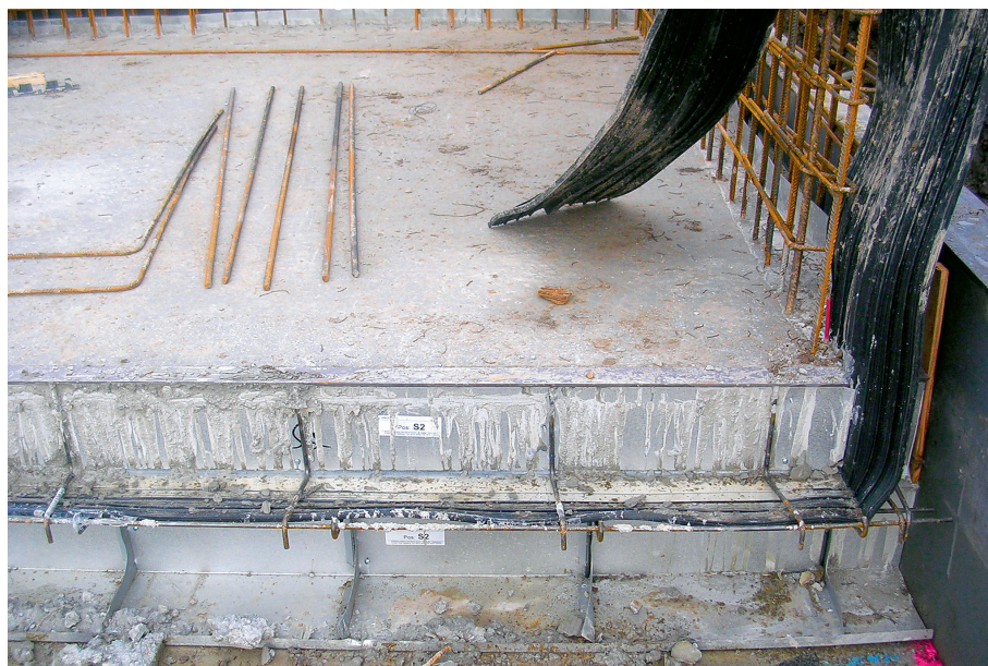
(3) Abschalelement mit innen liegendem Fugenband und Umlenkung in der Wand
