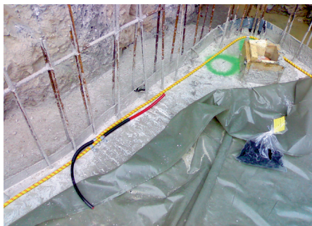
(6) Überlappend verlegte Injektionsschläuche
