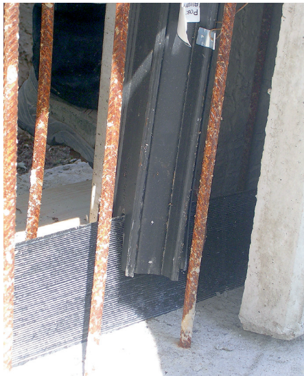
(5) Eingebautes Schwindrohr auf Arbeitsfugenband
