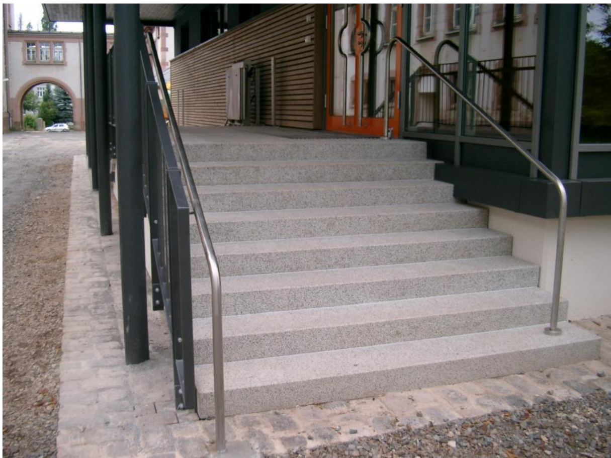
Bauvorhaben: Turnhalle Bildungszentrum Frankenberg Material: Terrazzo-Blockstufen und Podestplatte
