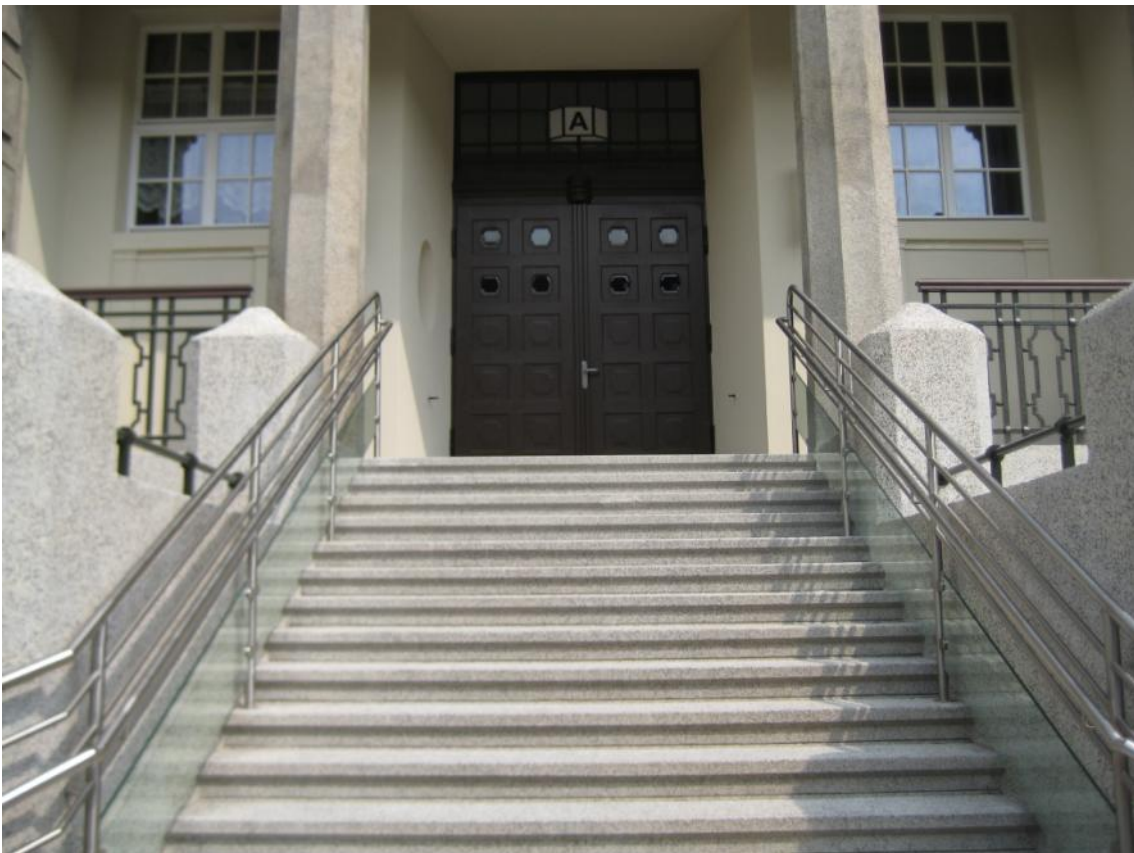
Bauvorhaben: Jan-Amos-Comenius-Schule in Chemnitz Material: Terrazzo-Blockstufen mit Profilierung
