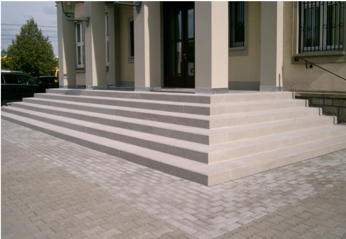
Bauvorhaben: TCC Chemnitz
