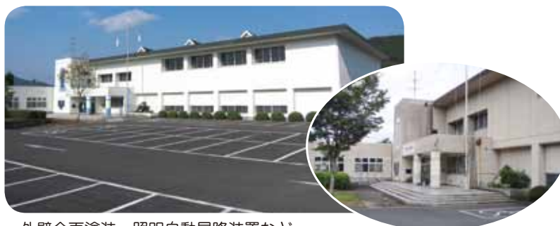
外壁全面塗装、照明自動昇降装置など、 新しく生まれ変わった 四万十町窪川B&G海洋センター(左)と工事前の写真(右)
