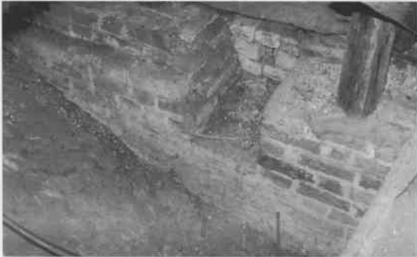
Abb. 7 Deckenbalkenaufleger in der nördlichen Außenmauer, Zustand 2001 (Foto St. Amt).
