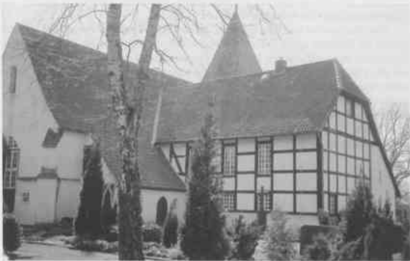
Abb. 2 Ansicht des Fachwerkanbaues von Nordosten, Zustand 2001 (Foto St. Amt).
