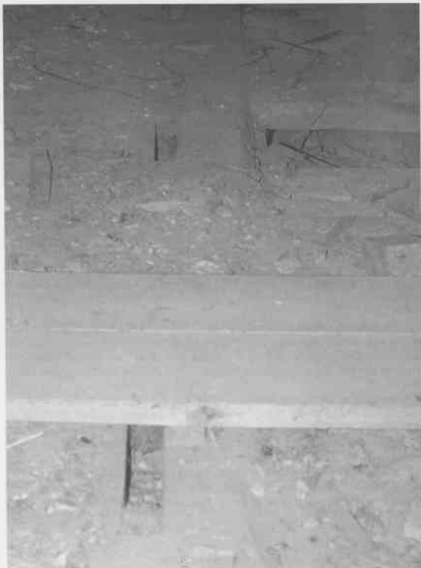
Abb. 14 Reihe der Zapfenlöcher im fünften Deckenbalken des Fachwerkanbaus, Zustand 2001 (Foto St. Amt).
