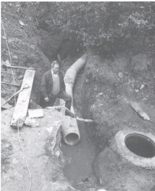
Connexió de la claveguera provinent dels carrers de Sant Pere, Sant Gaietà i part de Francesc Forgas de la xarxa general. Inexplicablement abocava sota la zona de l'arbreda, antic abocador de runes.
