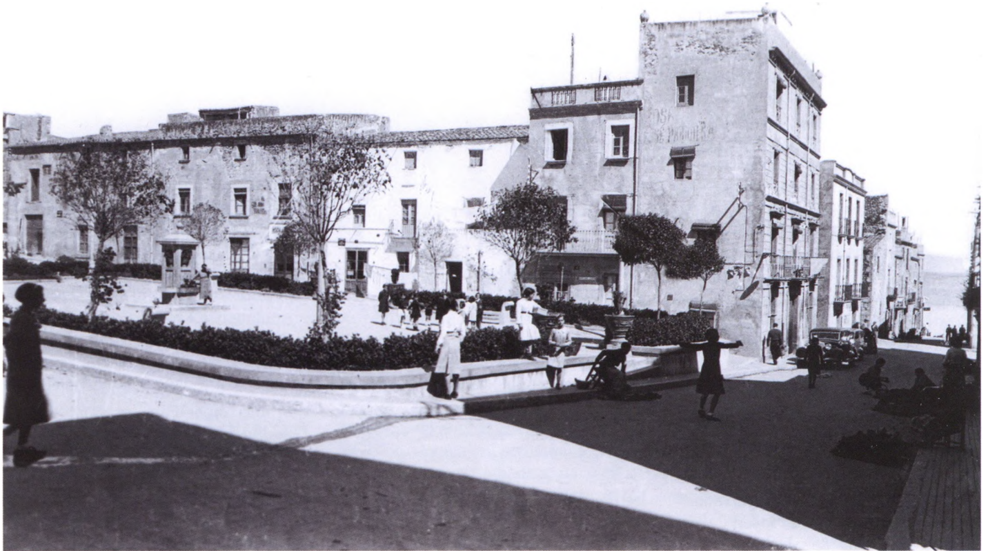
Fent xamfrà entre l'antic carrer de l'Hospital i el Sòl d'en Sagué (actual plaça Víctor Català), l'antiga fonda de cal Gambo o Centro, on Enrique Uranga visqué des de 1934 fins després de la Guerra Civil. Foto: V. Fagnoli. Col·lecció de l'autor
