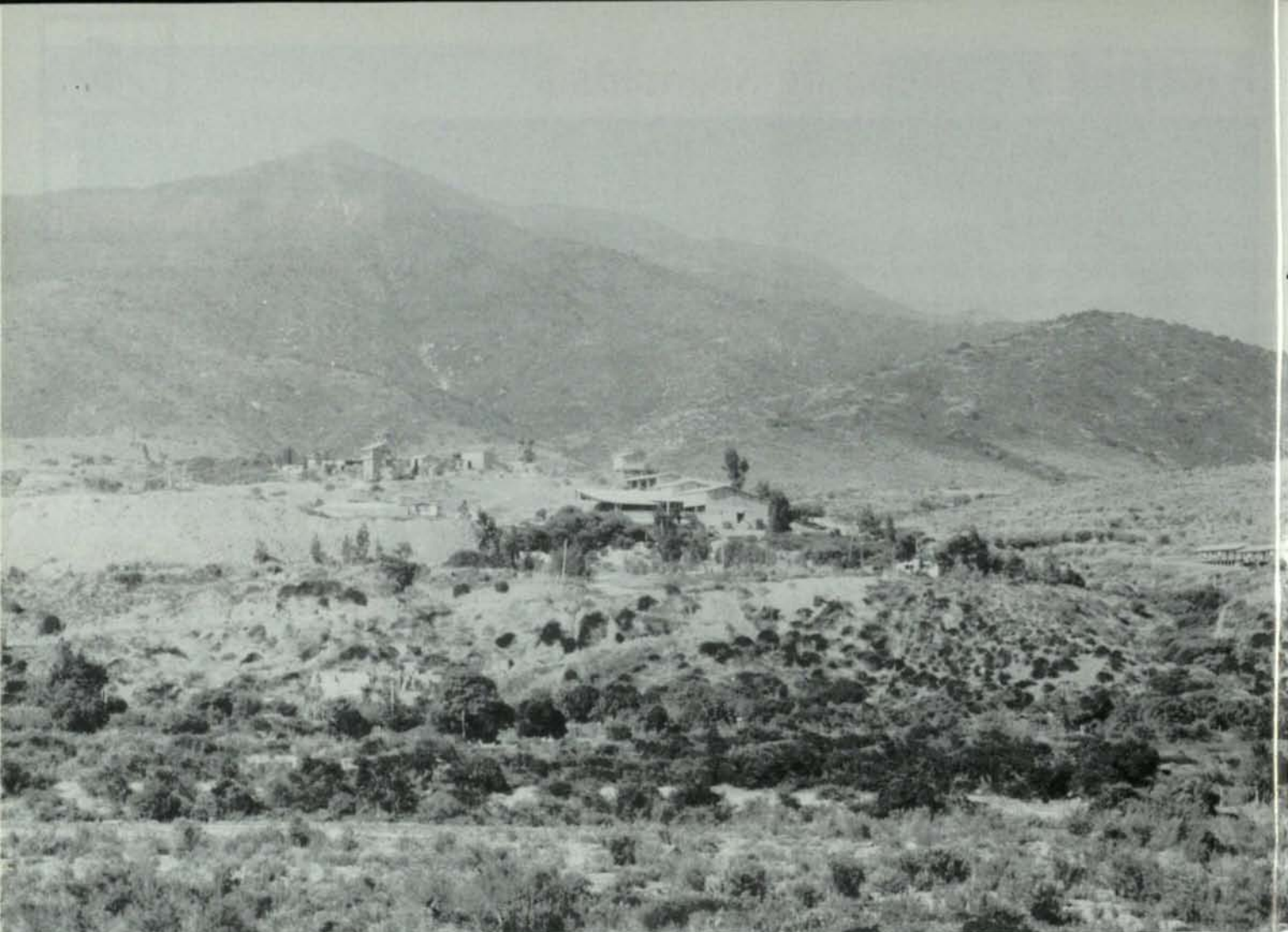
Minera Don Alberto explota la mina de oro del mismo nombre, ubicada en el fundo El Mollar, cerca de Los Vilos, en la Cuarta Región, y una planta de concentración de oro.
