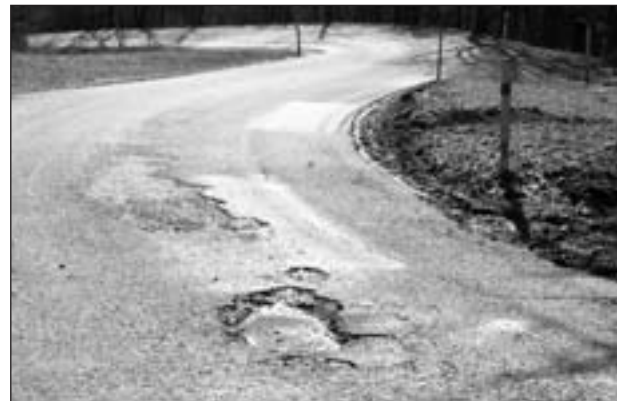
Löcher im Asphalt führen in der Region Biel-Seeland Berner Jura derzeit zu Verkehrsbehinderungen.
