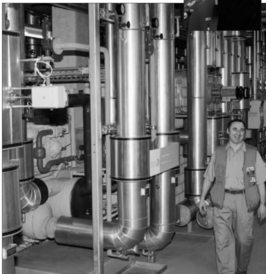
Wollen beim Energiesparen mit gutem Beispiel vorangehen: Jean-François Bürki (oben), Leiter Technik und Sicherheit, und Heizungsmonteur Markus Burri.
