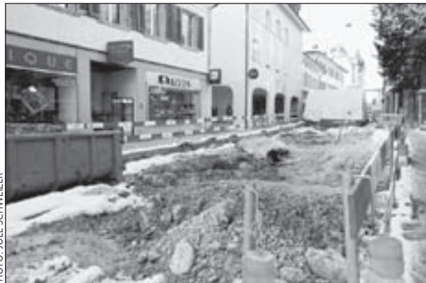
Baustelle Zentralstrasse, Moutier.
