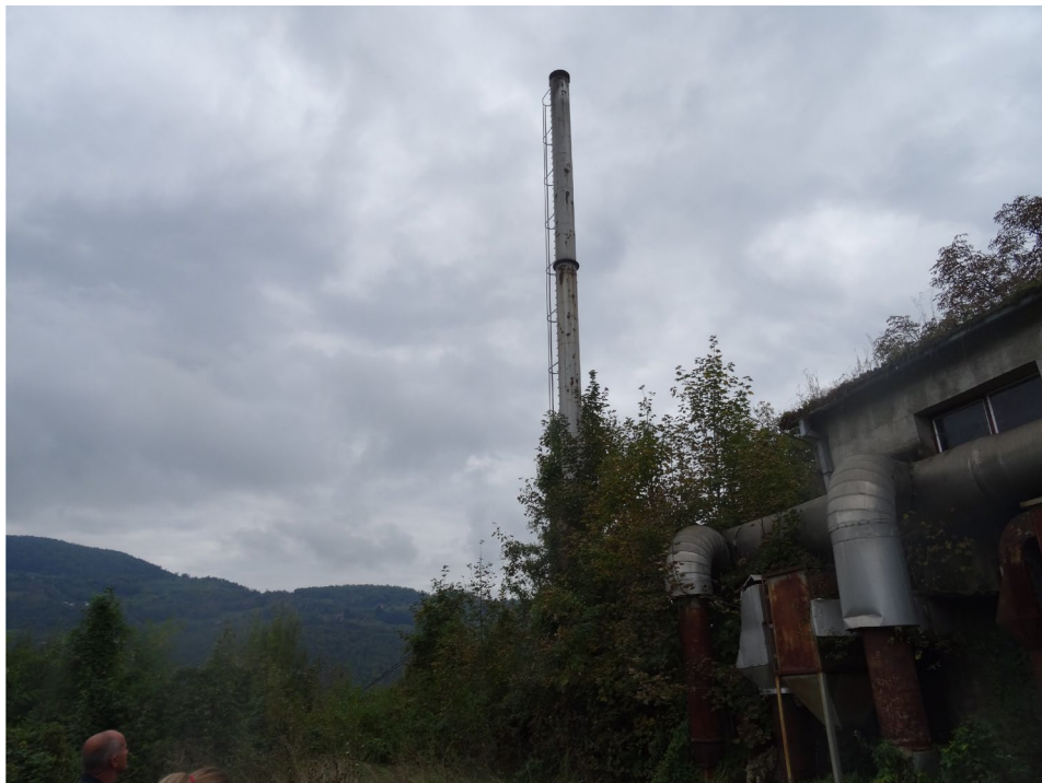
Slika 2.2. Izgled objekta na kojem se implementira projekat
