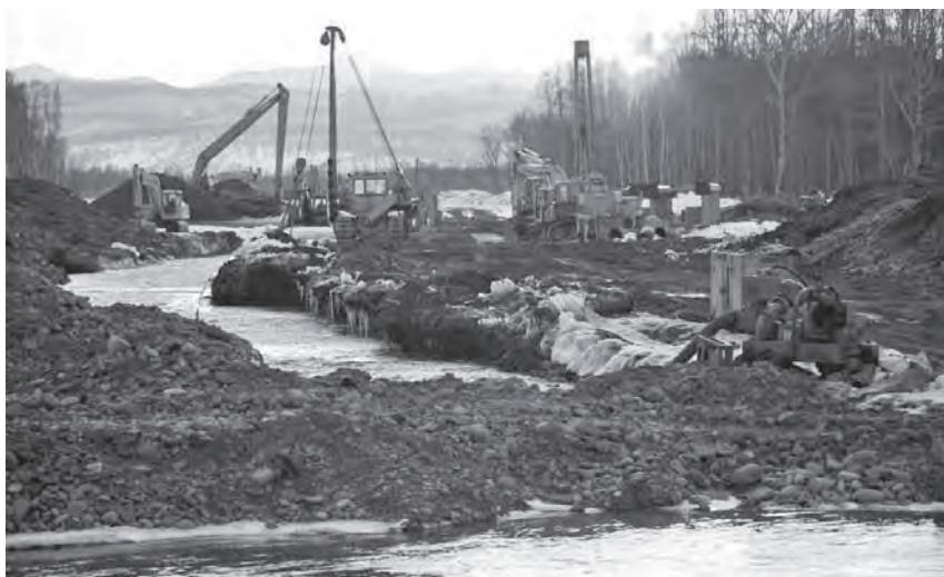
Рис. 2. Один из моментов реконструкции надземного перехода магистрального газопровода через р. Авачу (ноябрь 2011 г.). Фото О.А. Чернягиной
