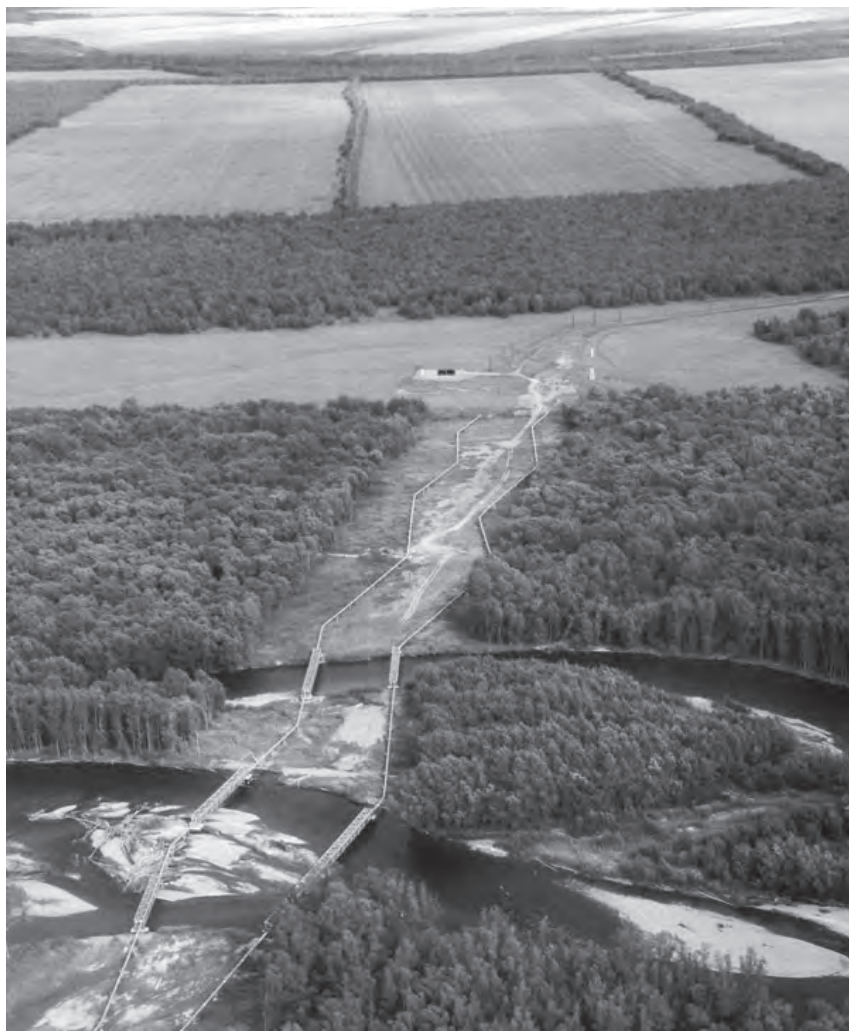
Рис. 1. Вид сверху на надземный переход магистрального газопровода через р. Авачу (август 2011 г.). Фото О.А. Чернягиной
