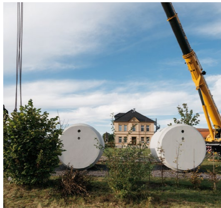
Baustelle „dasparkhotel_inside-outsight“, Foto: Daniel Sadrowski
