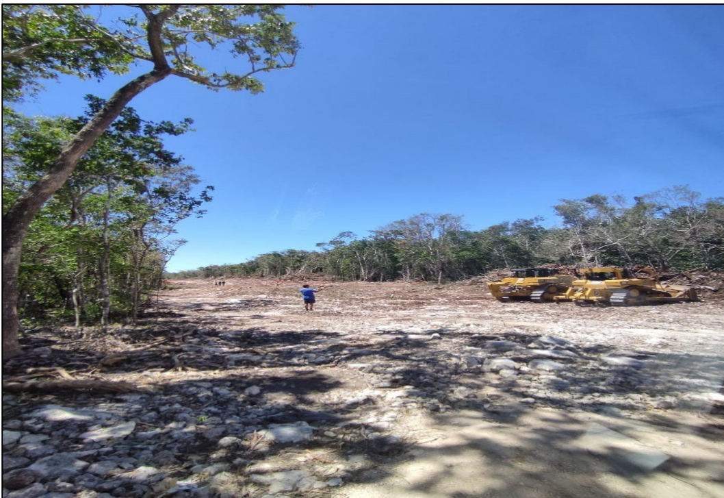
Figura 16. Desmante de vegetación en el Tren Maya Tramo 5 Sur, corresponde a vegetación de Selva Mediana Subperennifolia.
