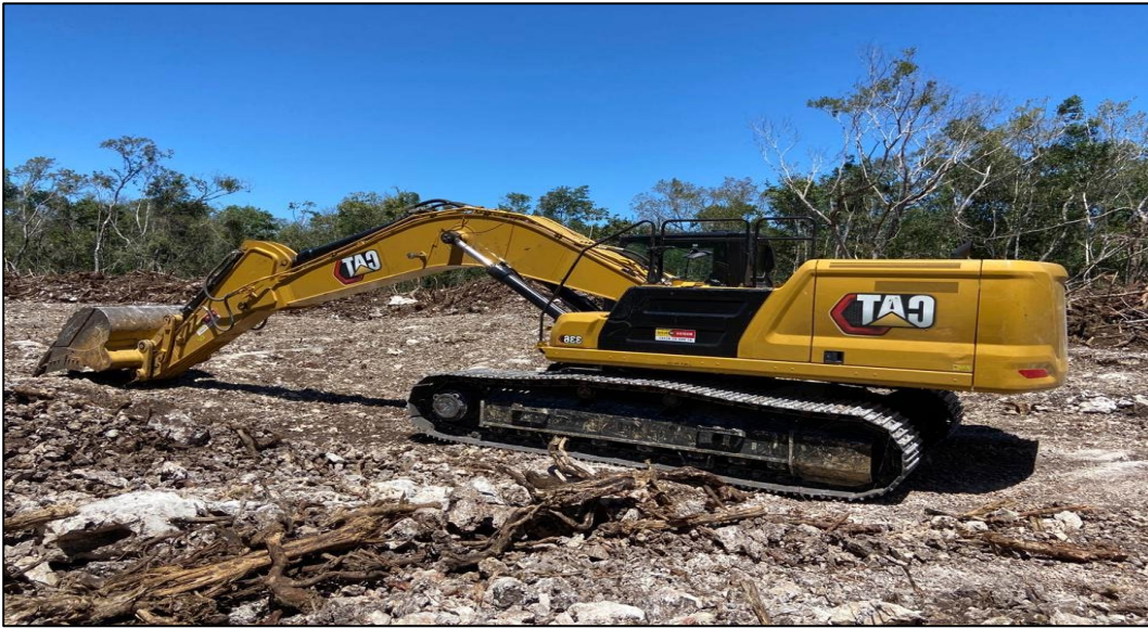
Figura 15. Desmante de vegetación en el Tren Maya Tramo 5 Sur, corresponde a vegetación de Selva Mediana Subperennifolia.
