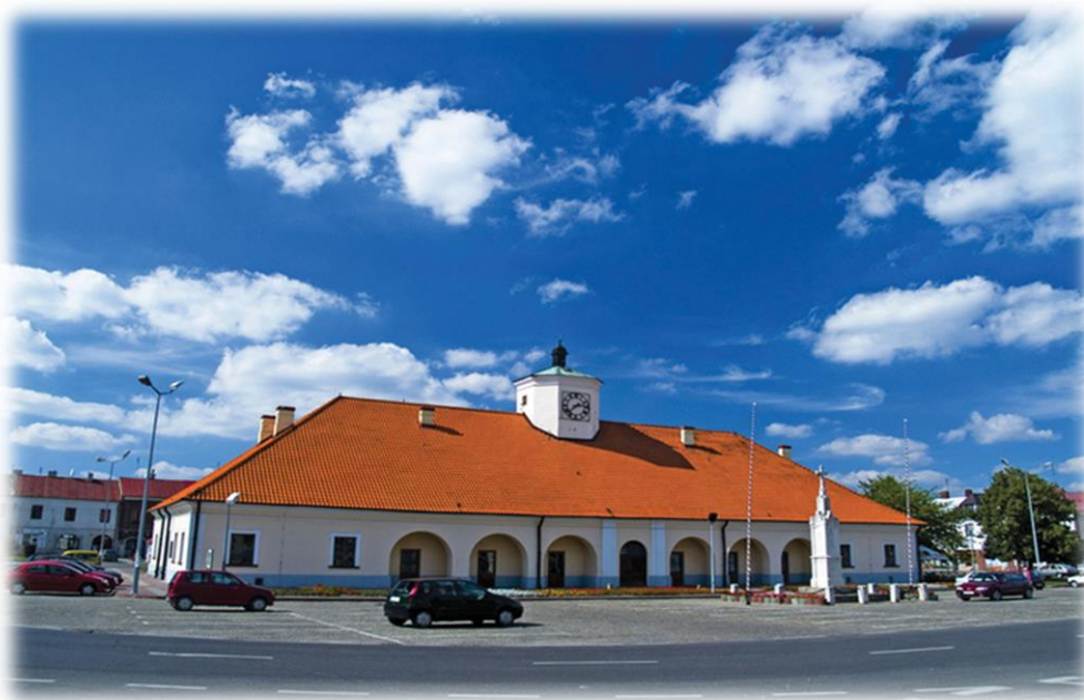
Fot. Nr 11. Ratusz w Staszowie, źródło: UMiG Staszów
