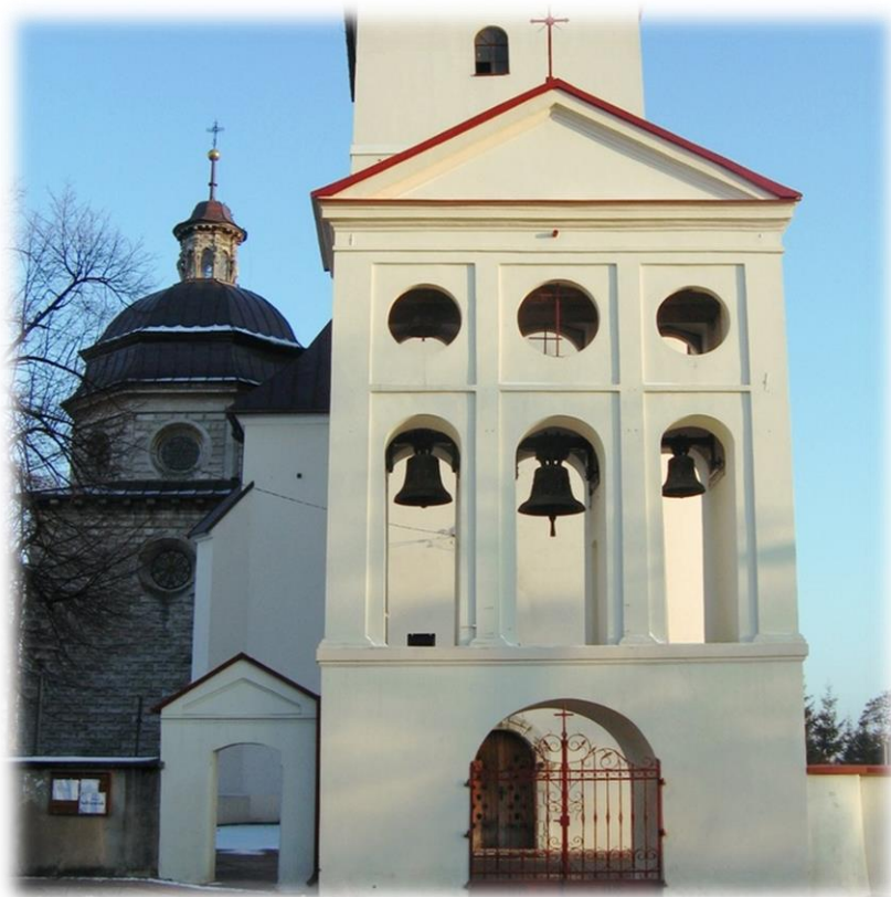
Fot. Nr. 14. Dzwonnica (przy kościele św. Bartłomieja), źródło: UMiG Staszów
