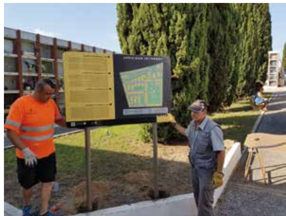
▲ Les Brigades municipals instal·lant els plafons de senyalització
