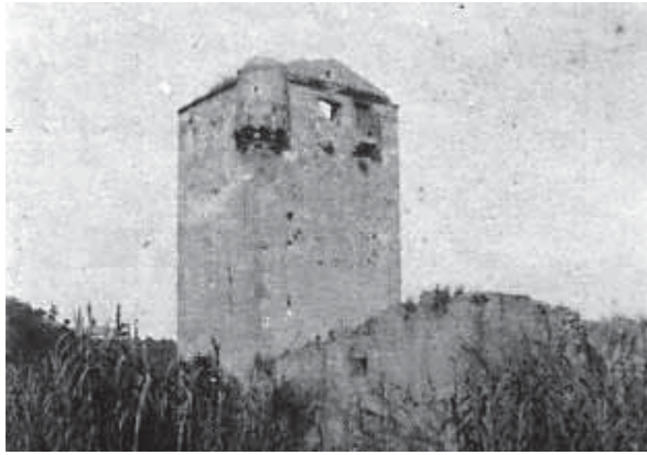
Figura 4. Torre de la Planera. Gastó de Montcada, II Marquès d'Aitona, va donar permís per a la seva construcció a Esteve Alemany i Florit el 26 de novembre de l'any 1599 ...per a més çeguretat de les persones qui estaran i habitaran en ella...
