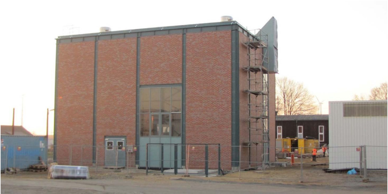
Abbildung D-11: Endlager Konrad in Salzgitter (Konrad 1: Fördermaschinengebäude Süd) (Bildrechte: BfS)
