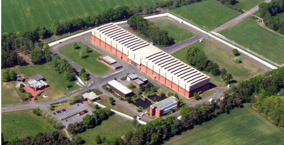
Abbildung D-4: Transportbehälterlager Ahaus für abgebrannte Brennelemente und radioaktive Abfälle (Bildrechte: GNS)
