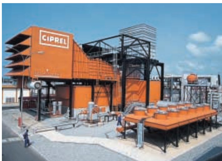
La centrale thermique de Vridi à Abidjan, en Côte-d'Ivoire
