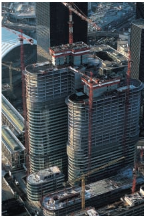
Le chantier de Cœur Défense en région parisienne
