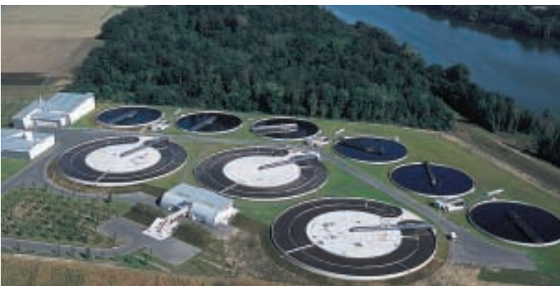
La station d'épuration d'Orléans
