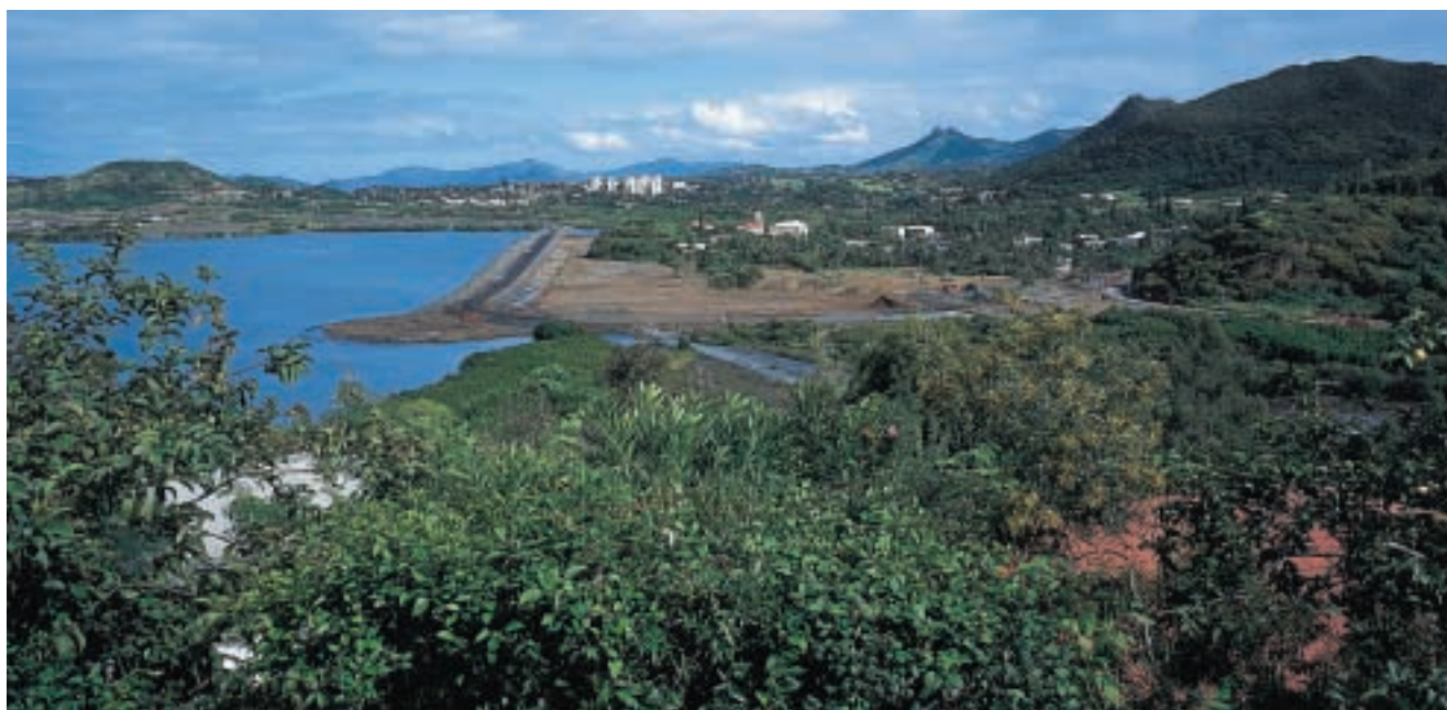
La voie de contournement de Nouméa en Nouvelle-Calédonie
