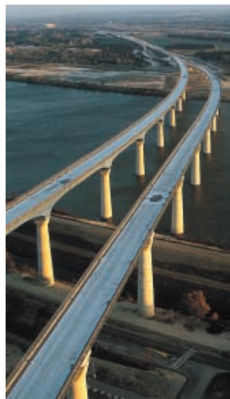
Les viaducs d'Avignon en Provence
