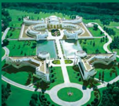
Challenger, siège social de Bouygues Construction
