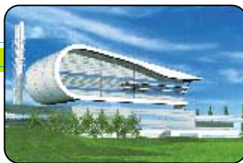
Dexia CLF a attribué 160 millions de francs (24,4 millions d'euros) de prêts de longue durée au Sertrid, maître d'ouvrage de la construction du nouveau centre de recyclage et de valorisation énergétique du Territoire de Belfort.
