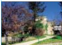
La rénovation de la Bastide de Chateauloin à Néoules (Var) a été financée par un prêt de 1 million de francs (152 449 euros) sur trente ans dans le cadre de l'enveloppe Perspectives 99.
