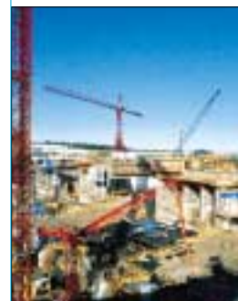
Les secteurs du bâtiment et des travaux publics ont dû faire face à une demande importante en 1999. Certains investissements ont dû être reportés sur l'année suivante.
