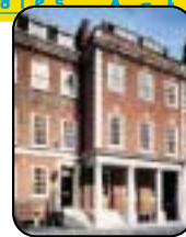
Depuis plusieurs années, Dexia Municipal Bank a développé sa présence sur le marché anglais du logement social, dont elle est aujourd'hui l'un des premiers intervenants. Siège de Dexia Municipal Bank.
