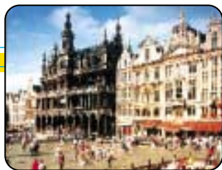
La banque a conseillé le consortium Suez Lyonnaise des Eaux - Tractebel pour répondre à l'appel d'offres lancé par la région Bruxelles Capitale pour la construction d'une station d'épuration des eaux.
