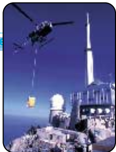
Dexia CLF est intervenu auprès du Syndicat mixte pour la valorisation touristique du Pic du Midi de Bigorre, en mettant en place un financement de 65 millions de francs (9,9 millions d'euros) sur 30 ans, pour la rénovation de l'observatoire.
