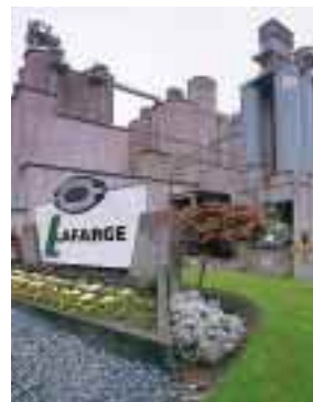
ÉTATS-UNIS Cimenterie de Seattle dans l'Etat de Washington - Lafarge Corporation
