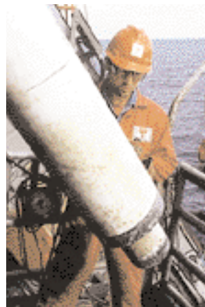
Pose de conduites à double enveloppe sur BP Nile
