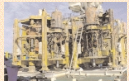
Récupération d'une structure sous-marine sur Tommelitten
