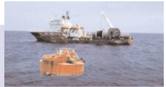
Installation d'une bouée CALM par le navire Seamec III sur Bongkot
