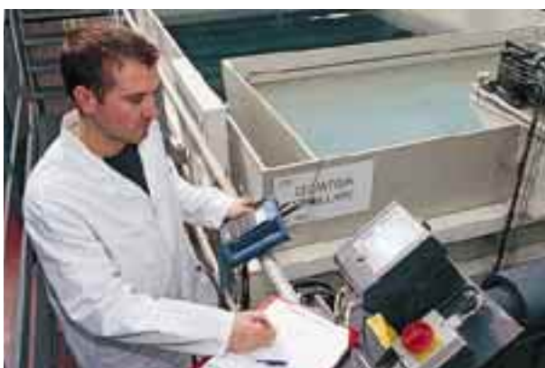
Stations autonomes de traitement des eaux rejetées. La Suze s/Sarthe – France. Branche Thermique Habitable.
