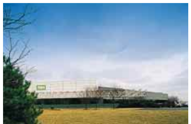
Stations autonomes de traitement des eaux rejetées. Hamilton – États-Unis. Branche Thermique Habitable.
