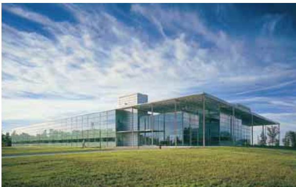
Centre Technique Auburn Hills – États-Unis. Branches Thermiques Moteur et Habitacle.
