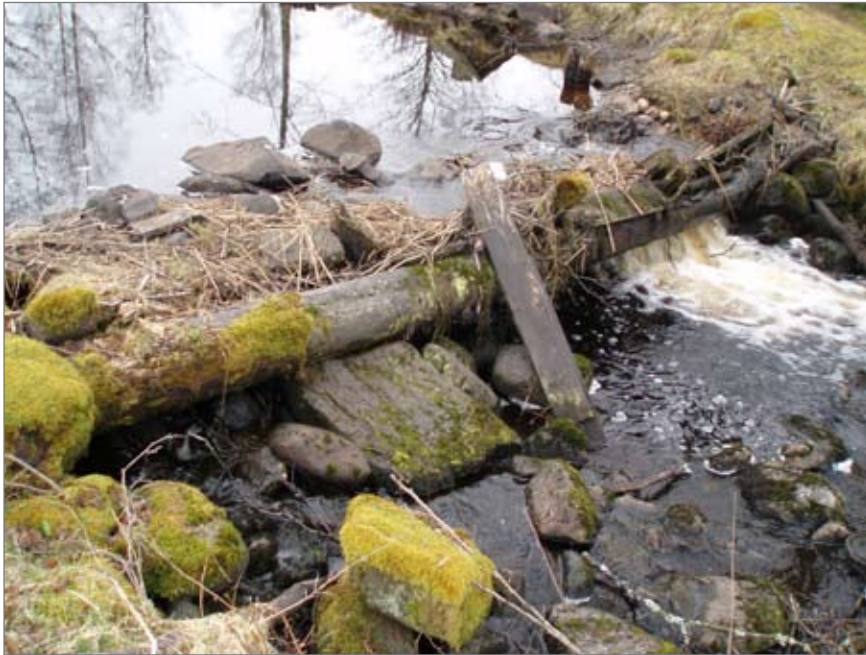
3. Närbild på fördämningsvallen.
