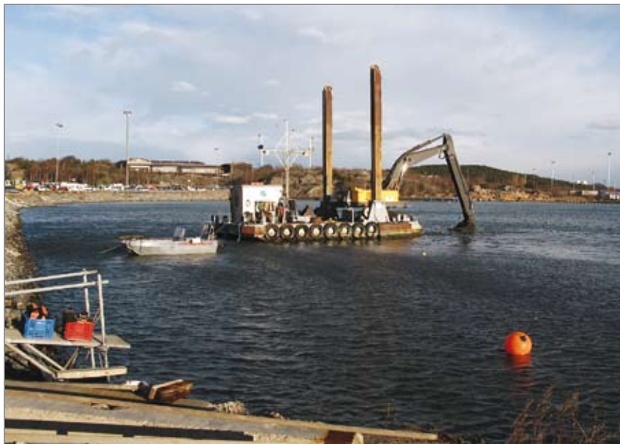
Figur 16. Grävmaskin under schaktning av farledsspärr 1. Foto mot nordnordost: Boel Bengtsson.
