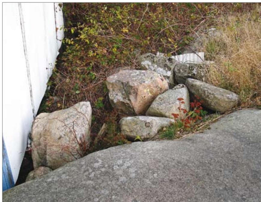
Figur 33. Stenar norr om Göteborg 367 som kan komma från husgrundens nordvästra hörn. Foto från väster: Mattias Öbrink.
