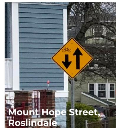
La señalización avisa a los conductores que entran en la calle de la circulación bidireccional de bicicletas
