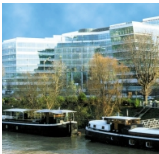
The Espace Seine in Levallois-Perret (France).
