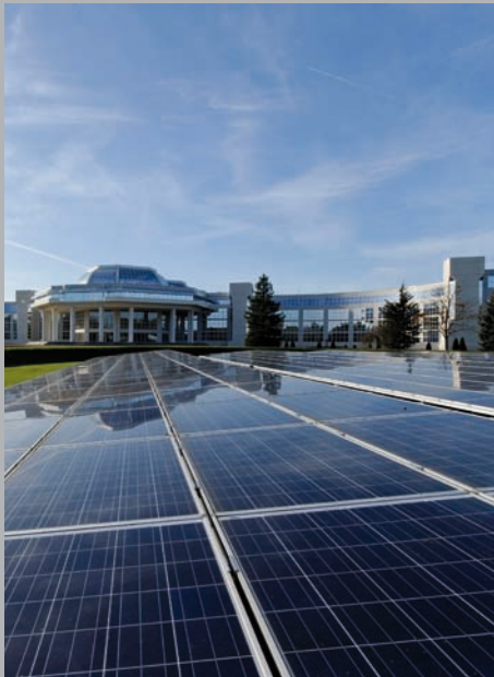
Challenger, siège social de Bouygues Construction, en cours de rénovation environnementale
