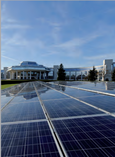
Challenger, sede social de Bouygues Construction, en fase de reforma medioambiental
