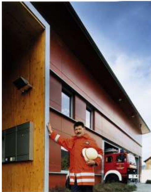
Ein Feuerwehrgerätehaus aus Holz; Foto: HAF (www.infoholz.de)
