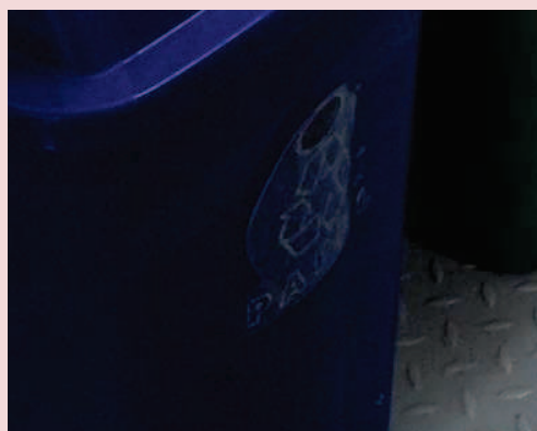
Foto 5-8. Adesivo no coletor presente na sala de controle da casa de força da PCH (papel).
