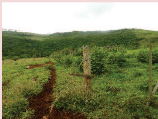
Foto 5-15. Vista da integridade do cercamento em trecho da margem direita do reservatório.
