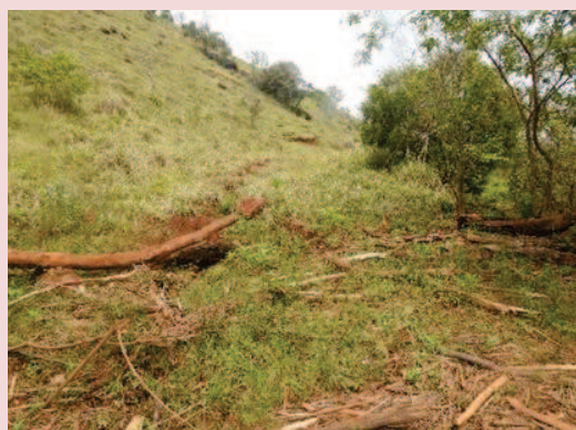
Foto 5-7. Vista parcial da erosão próxima da via carroçável construída na margem esquerda do reservatório, na propriedade J.M. Virmond.
