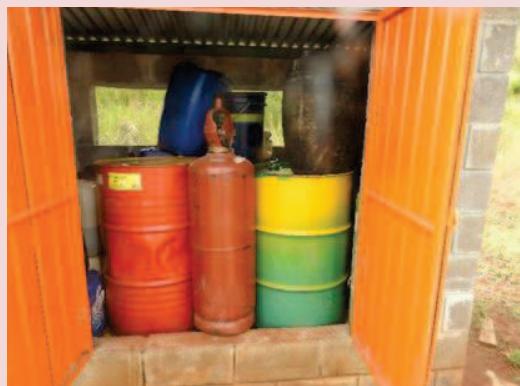
Foto 5-17. Vista interna de um dos compartimentos (Resíduos Perigosos), indicando o armazenamento de produtos oleosos - 2º semestre.
