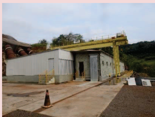
Foto 5-3. Vista geral da área externa da casa de força da PCH Cantú 2.
