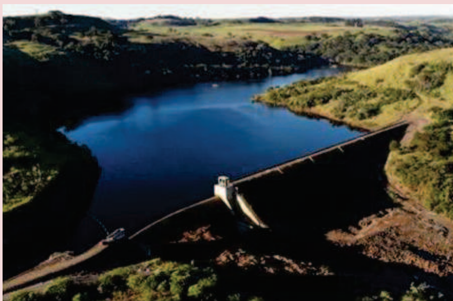
Foto 5-19. Vista aérea do Barramento da PCH Cantú 2, Rio Cantú, Paraná.
