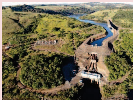
Foto 5-1. Vista aérea da casa de força e da alça de vazão reduzida da PCH Cantú 2.
