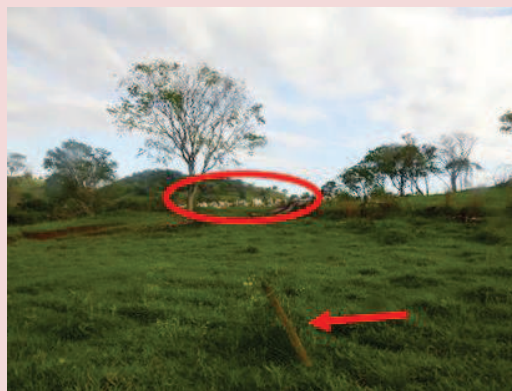
Foto 5-18. Vista de gado (círculo) na margem esquerda do reservatório com passagem livre em cercamento deteriorado e tombado (seta).
