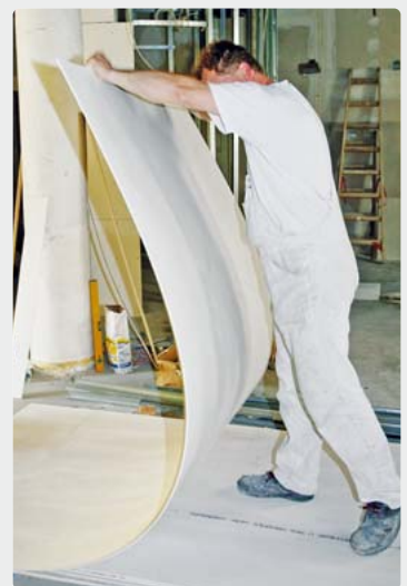
Vor der Montage werden die Platten behutsam gedehnt, um die großen, vliesarmierten Platten biegsam zu machen. Foto: Saint-Gobain Rigips GmbH
