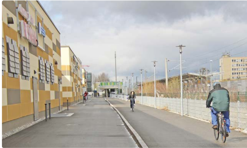
Sturzgefahr durch Randstein: Der Fuß- und Radweg zwischen dem Einkaufszentrum und der Bahnlinie am Oertelplatz sorgt bisweilen für Unmut. Bild: sb
