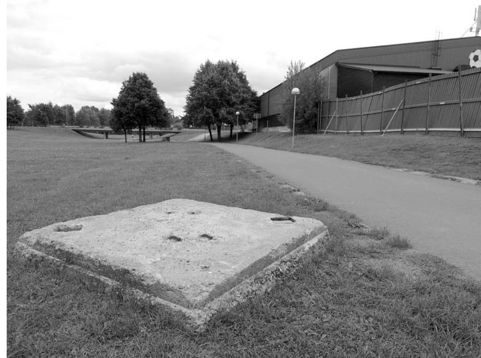
Ett sparat fundament till ett av de fyra benen till en av radiomasterna
