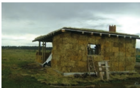
↑ Casa de fardos de paja con muro no portante, en construcción. Rocha, Uruguay. Foto: Laura Astigarraga
