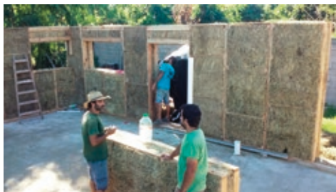
↑ Construcción con panel prefabricado. Solymar, Canelones. Foto: Martín Varela
