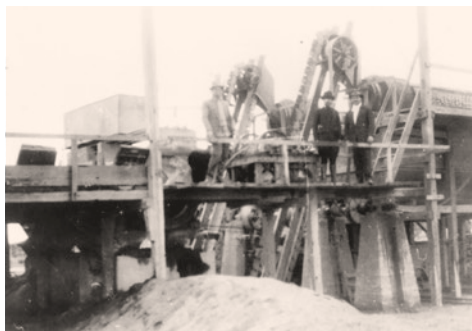
↑ Moledora de piedras, en la isla San Gabriel construida por la empresa alemana Dykeroff y Widman. 1929
