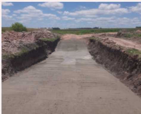
↑ Figura 8. La solución consiste en adecuar la estructura, para que no genere un embalse que represe las aguas temporalmente y las haga salir fuera del cauce, sino que escurran por el viejo cauce, atravesando el badén de hormigón. Este badén tiene 8 metros inclinados a cada lado del centro del cauce con 5 metros, cuando el máximo nivel que puede ascender el nivel del agua sería 0,9 metros, o sea a la mitad de la profundidad total del cauce. La tierra que falta remover hacia ambos taludes será para nivelar y recuperar el área donde se estaba formando un cauce nuevo
