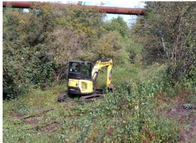
Abbildung 102: Rodungsarbeiten im gehölzreichen nordöstlichen Teil der Gleisharfe im September
