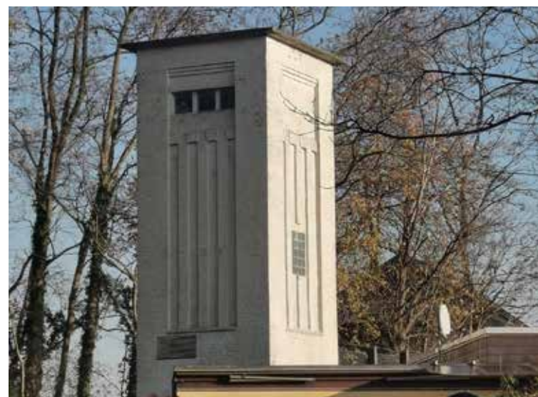
Abbildung 108: Der Trafoturm am Rand der Bebauung von Baerl zum Baerler Busch (Foto H. Rempel, RVR)
