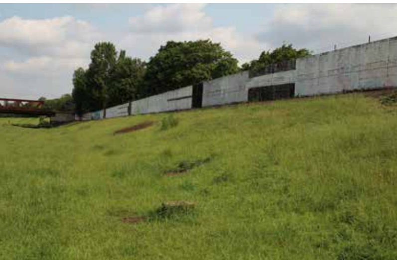
Abbildung 81: Deich im äußeren Ruhrbogen
