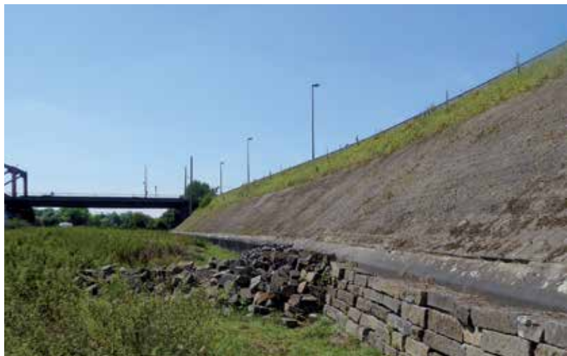
Abbildung 124: Situation am Pontwert nach der Maßnahme (August 16)
